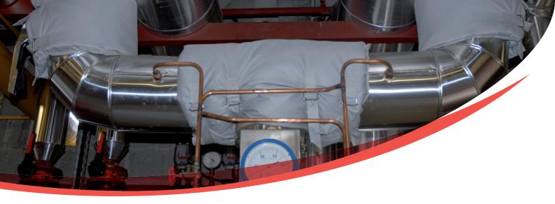
Des matelas souples faciles à monter et à démonter pour les opérations de maintenance.
